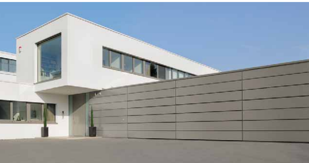
Bekleding door de klant met aluminium sandwichplaten
