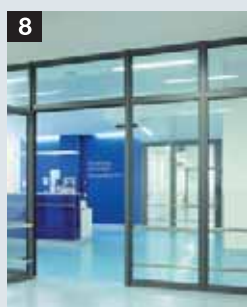
8 Brand- en rookwerende elementen met omraming uit koperprofiel
